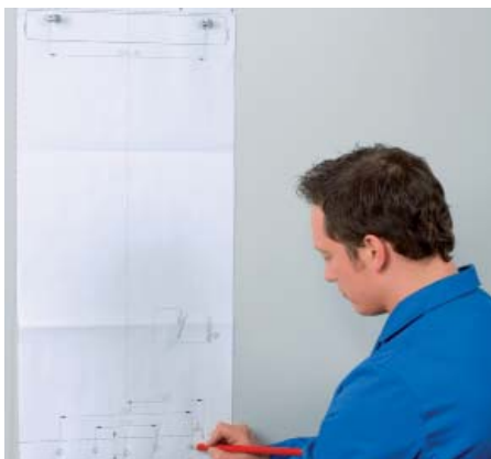
1. Pregătirea montajului cu ajutorul șablonului
